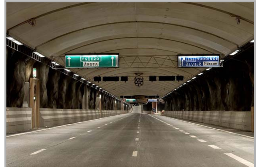
Södra Länken, Stockholm. Concrete roof, bare walls. Foto: Mikael Ullén
